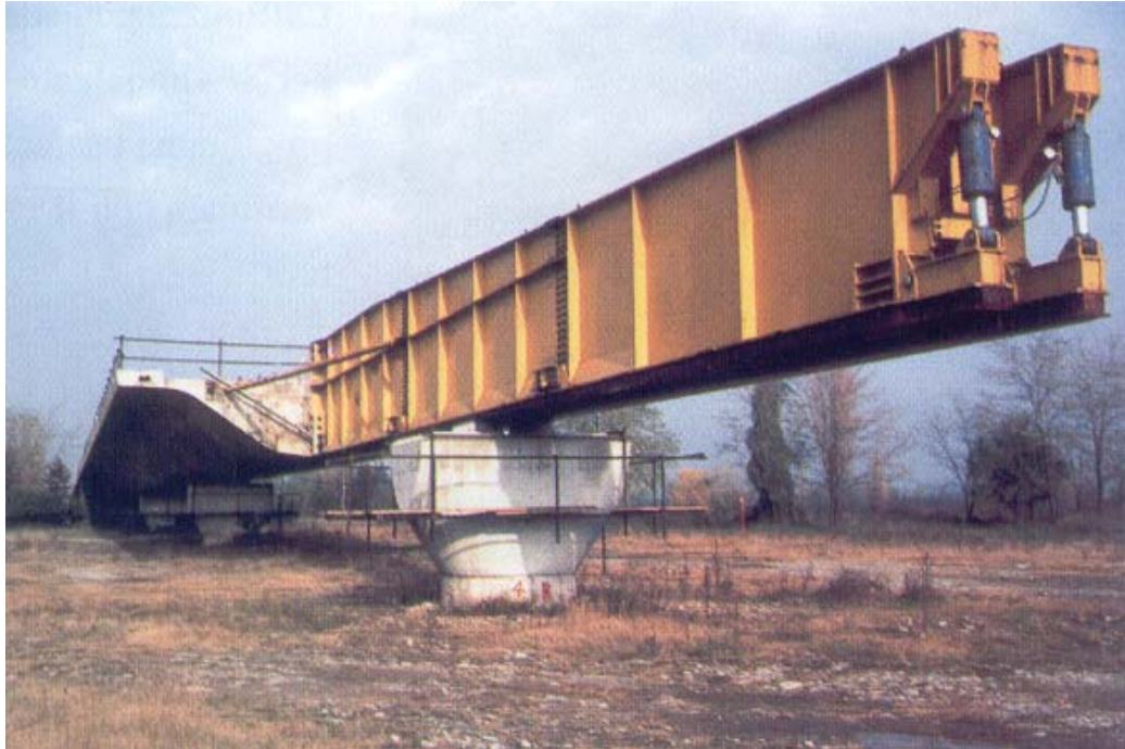
L'avambecco per l'avanzamento dell'impalcato [F15].
