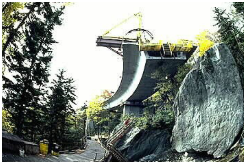
Fig. 1.4: Il ponte Linn Cove [F2].
