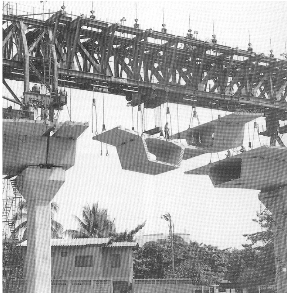
Movimentazione del concio per la messa a dimora [F9].
