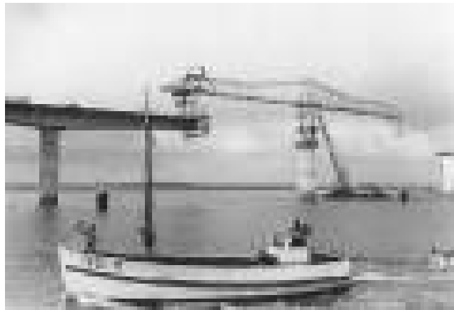
Fig. 1.2: Il carro varo del viadotto Oleron, 1964-66 [F2].
