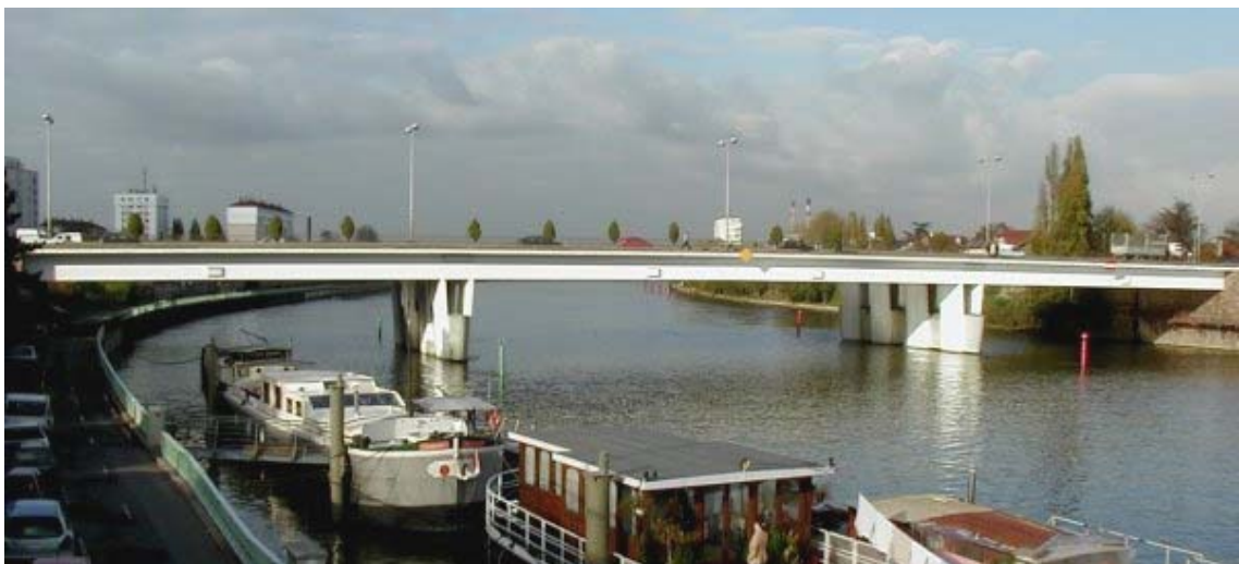
Fig. 1.1: Il ponte Choisy-le-Roi, 1962 [F2].
