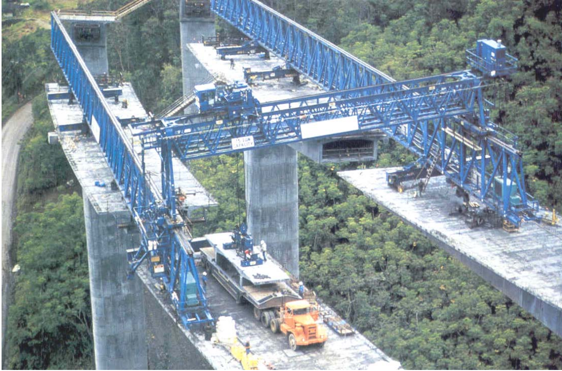
Fig. 5.16: Il sistema costruttivo adottato ha permesso di porre in opera in una giornata otto conci, compresa la saldatura dei giunti e la predisposizione della precompressione.
