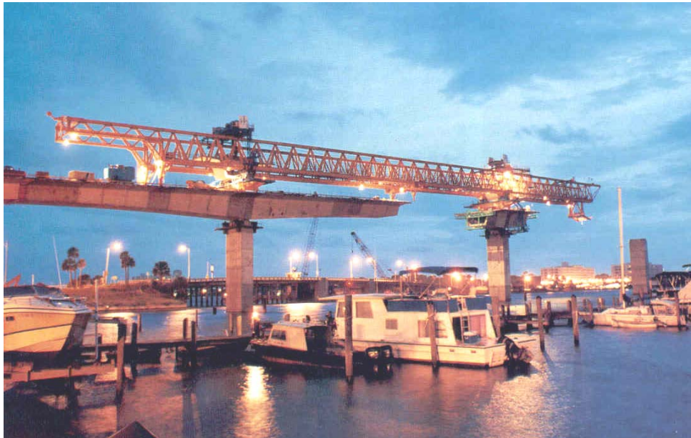
Fig. 5.12: I lavori di costruzione della nuova struttura di attraversamento articolati su tre turni non hanno condizionato la normale funzionalità del canale navigabile.
